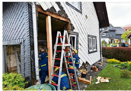
Mit einem Stützpfiler sichern Feuerwehrleute den Balken in der Garage. Foto: Karl-Wolfgang Fleißig
