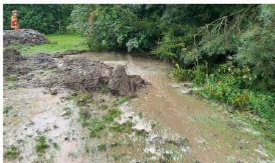
Das Wasser sucht sich seinen Weg, da die Verrohrung des Bachs verstopft ist. Foto: Feuerwehr Döhlitz
