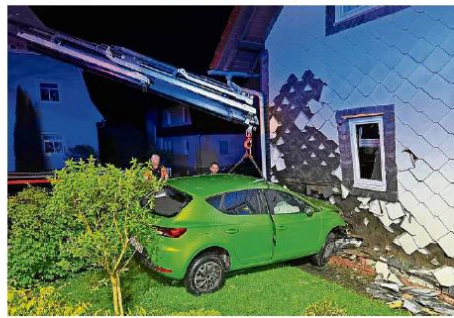
Das Unfall-Fahrzeug musste mit einem Kran aus der Hauswand geborgen werden. Foto: Stefan Hög
