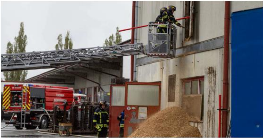
Mithilfe einer Drehleiter tragen Feuerwehrleute Schicht für Schicht aus dem Hackschnitzelsilo ab.
