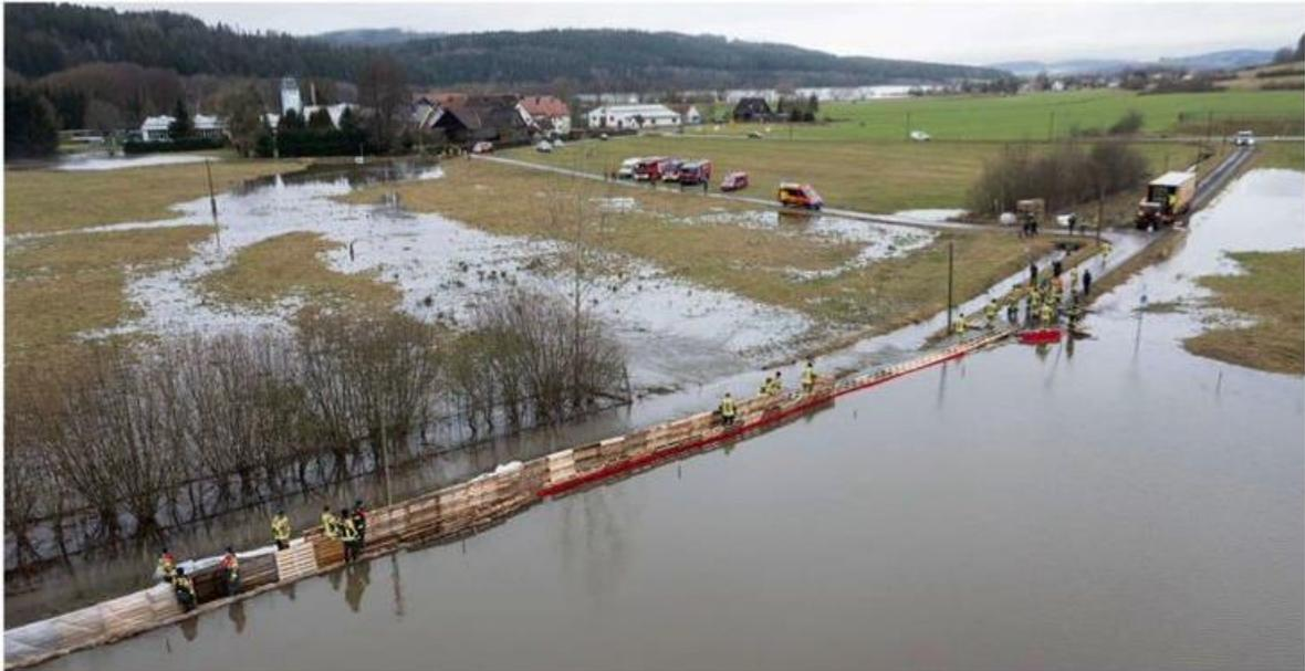
Ein mit Paletten erhöhter Damm konnte in letzter Minute verhindern, dass das Hochwasser in den Schleusinger Ortsteil Oberrod hineinläuft.
