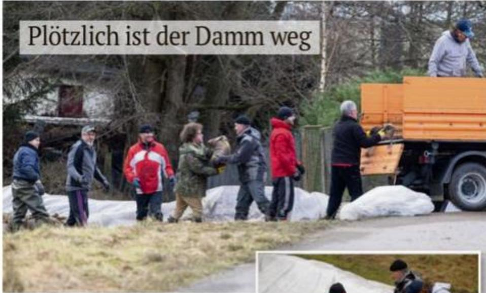
Hand in Hand arbeiten die Einsatzkräfte am Mittwoch in Oberrod, um den künstlichen Damm aus Euro-Paletten mit Folie, Sandsäcken und mobilem Hochwasserschutzsystem aus Plastik zurückzubauen.
