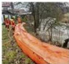
Feuerwehrleute installieren ein mobiles Hochwasserschutzsystem in Einöde Oberrod, Sachsoorbrunn.
